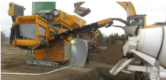
**Flüssigboden:** Bei der Übergabe des Boden- Compound- Gemenge wird eine entsprechende Menge Wasser in den Fahrmischer gepumpt. Der Flüssigboden wird chargenweise hergestellt und mit Lieferschein dokumentiert. Im Fahrmischer wird er 10- 90 Minuten lang vermengt und dann vergossen.
